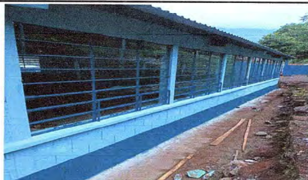
Foto 4: Instalacion concluida de balcones en los diferentes mudulos
