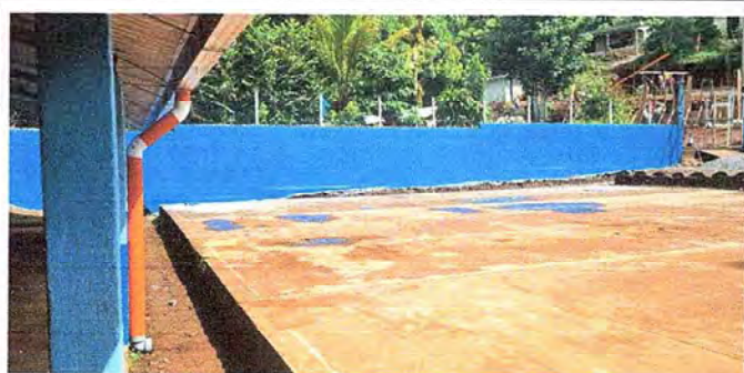
Foto 5: Finalizacion de muro perimetral pintado y terminado listo
