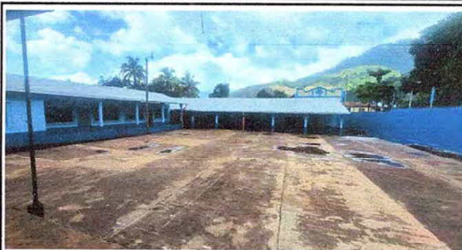
Foto 2: Proceso finalizado de pintado de muro perimetral , Intalacion de canales de agua y modulos pintados en su totalidad
