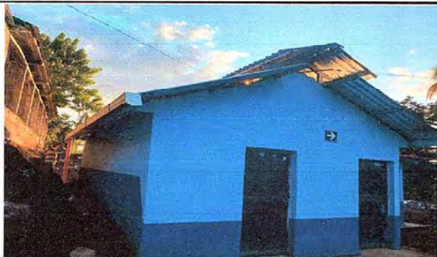
Foto1: Entechado metalico al modulo de cocina con los cambios de pintura, costaneras y laminas finalizado
